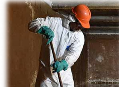
MANTENIMIENTO DE CISTERNAS
